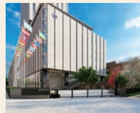
東池袋駅側のエントランス
